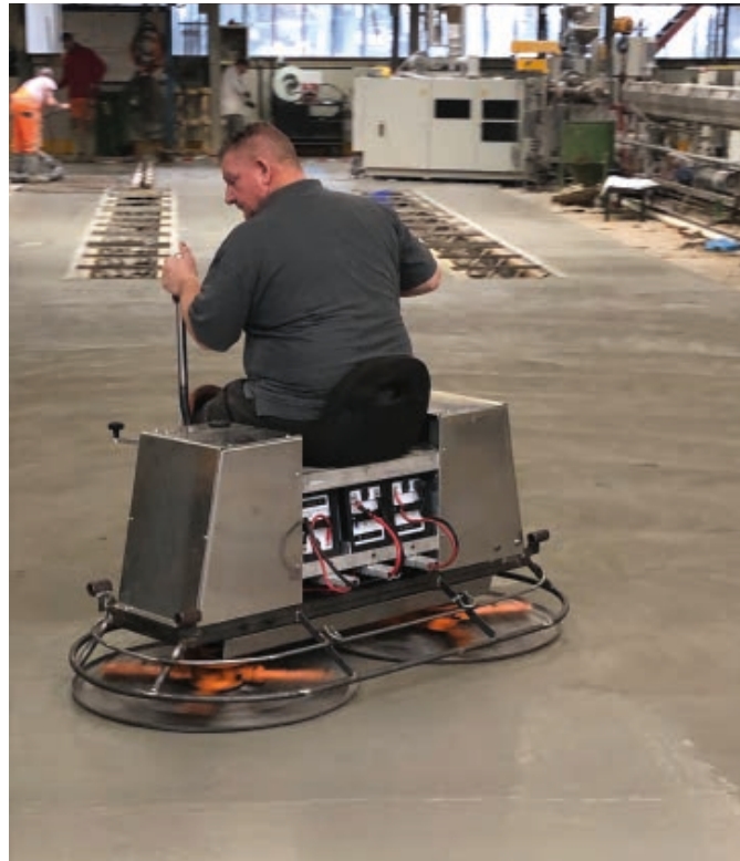
Zelfs de meest sceptische medewerkers omarmen de accuvlinder, omdat ze er veel nauwkeuriger mee kunnen werken.
